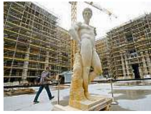
Baustelle des Humboldt-Forums mit einer enthüllten Kolossalfigur Foto: dpa
